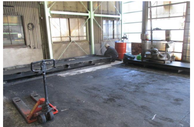
油漬け作業場改修 （微かな油も流出させない）
